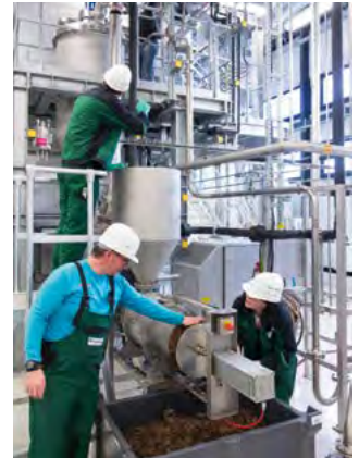
Schneckenpresse zur Vorentwässerung der festen Phase nach einem Aufschluss
